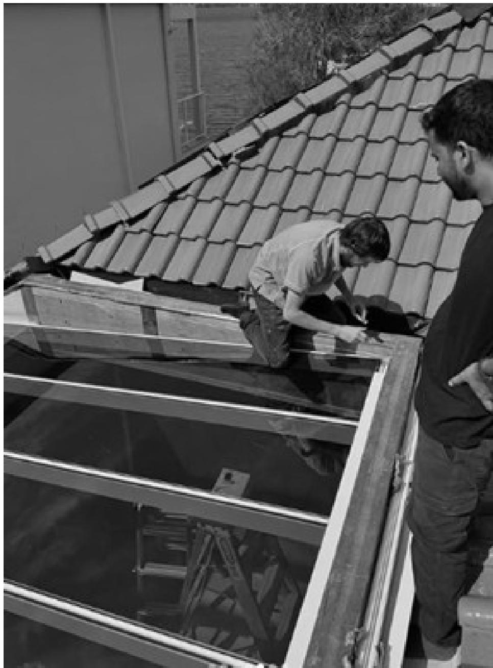
La imagen muestra a dos trabajadores en un tejado inclinado cerca de un tragaluz de cristal, con uno de ellos trabajando activamente en la estructura. Existen importantes riesgos de seguridad, ya que ninguno de los trabajadores parece estar utilizando un equipo de protección contra caídas, como un arnés o una línea de vida anclada. Además, el trabajador está situado justo encima de la abertura del tragaluz, lo que aumenta el riesgo de caída. La
