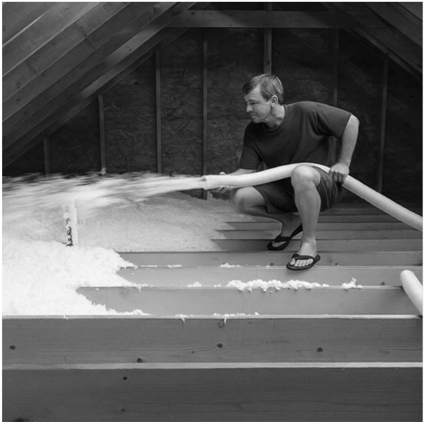
El trabajador está aplicando aislamiento en un ático sin ningún equipo de protección personal (EPP) visible. Lleva una camiseta, pantalones cortos y chanclas, dejando su piel completamente expuesta. Tampoco hay rastro de mascarilla antipolvo, gafas protectoras o guantes, todos ellos elementos esenciales cuando se
