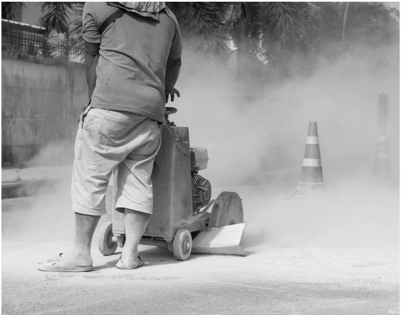
En la imagen, un trabajador maneja una máquina cortadora de hormigón en medio de una nube de polvo sin ningún equipo de protección individual (EPP) visible. El trabajador está expuesto a sílice cristalina respirable, que puede causar enfermedades pulmonares graves como la silicosis. Además, la persona lleva zapatos abiertos y no lleva guantes, lo que deja los pies y las manos expuestos a residuos afilados o al contacto con la máquina.
