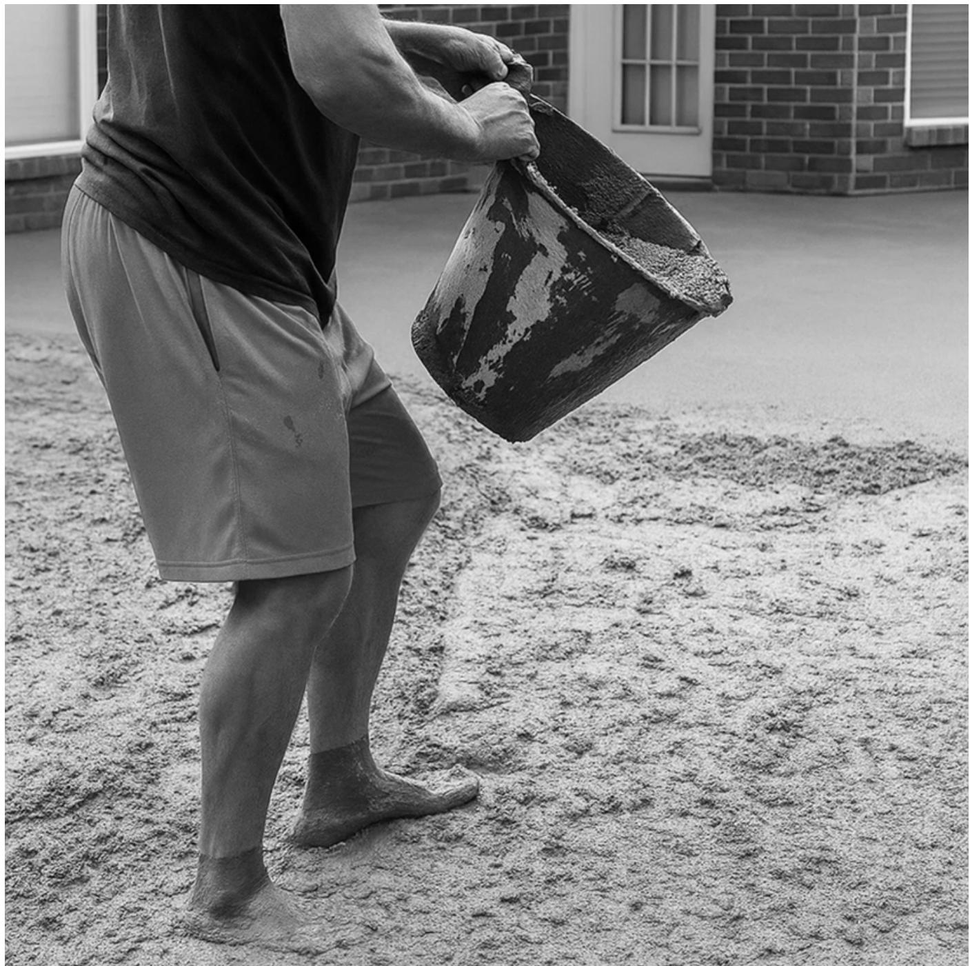
La imagen muestra a un trabajador descalzo sobre hormigón húmedo mientras lleva pantalones cortos. Esto es muy peligroso, ya que el contacto prolongado de la piel con el hormigón húmedo puede provocar quemaduras químicas, comúnmente conocidas como quemaduras por hormigón. La naturaleza alcalina del hormigón puede degradar el tejido cutáneo con el tiempo, a menudo sin dolor inmediato, lo que puede provocar lesiones graves.
